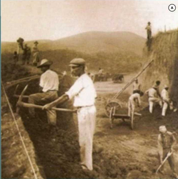
Figura 9 - (a) Transporte de materiais com ferramentas manuais e tração animal; (b) Uso de moto-scrapers com push; (c) Trator de esteira; (d) Escavadeira hidráulica.
