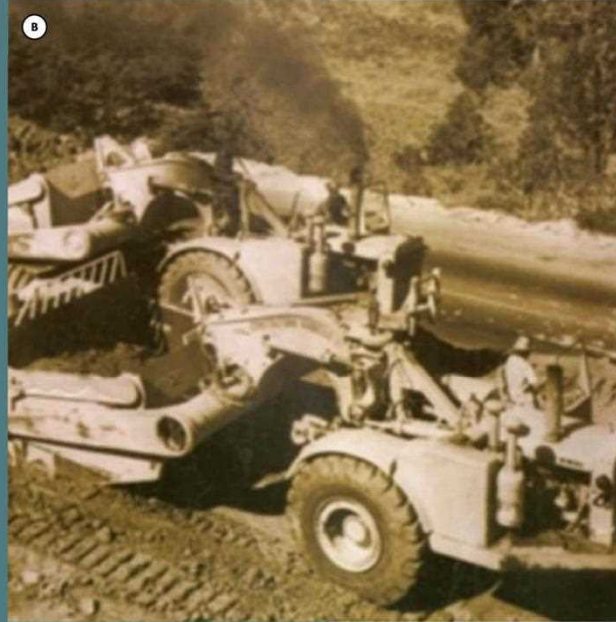
Figura 9 - (a) Transporte de materiais com ferramentas manuais e tração animal; (b) Uso de moto-scrapers com push; (c) Trator de esteira; (d) Escavadeira hidráulica.
