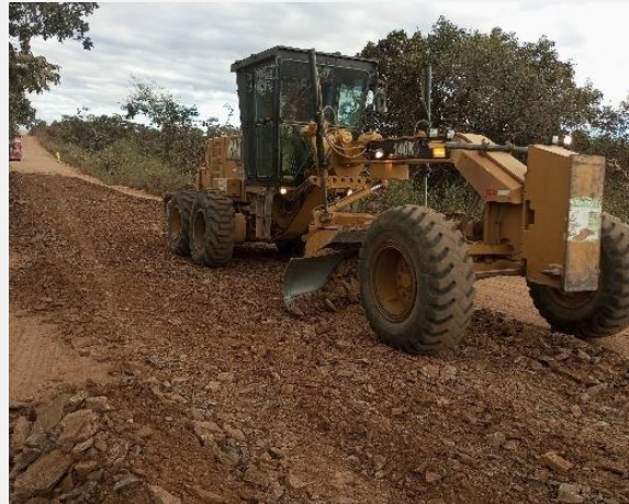
Imagem 37 – Revestimento Primário
