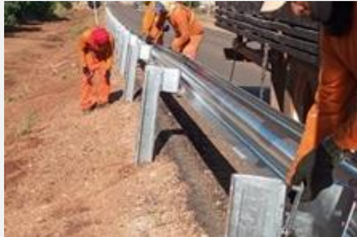
Imagem 34 – Recomposição de defesa metálica
