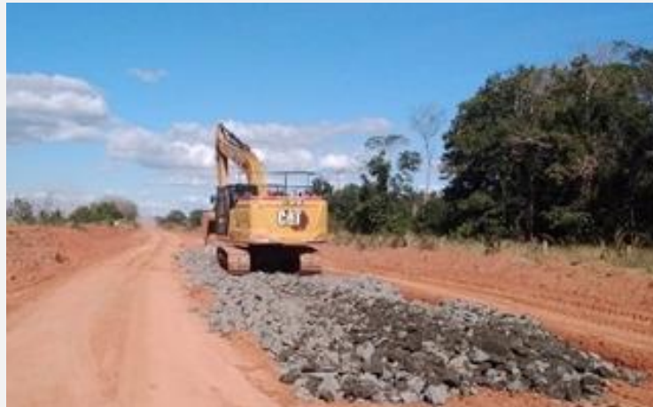
Imagem 33 – Execução de Colchão Drenante
