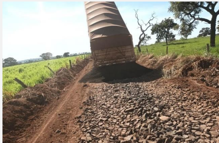
Imagem 31 – Estabilização com Rocha
