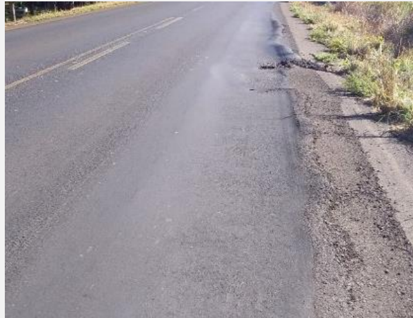
Imagem 5 – Deformações na pista
