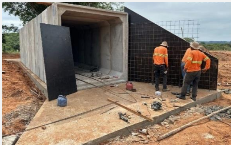
Imagem 35 – Execução de Bueiro Celular
