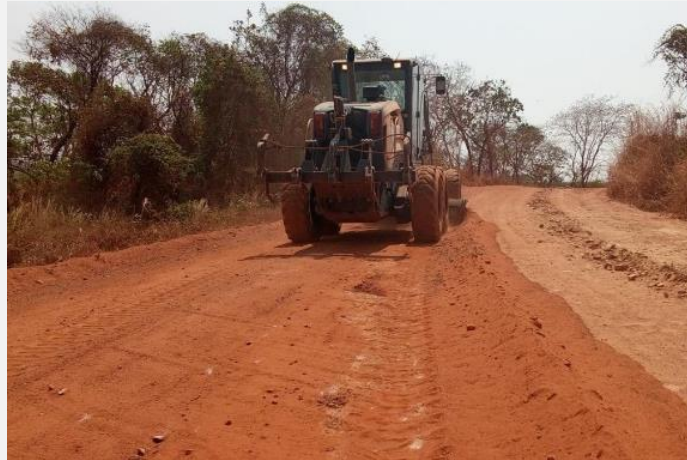
Imagem 36 – Reconformação da plataforma
