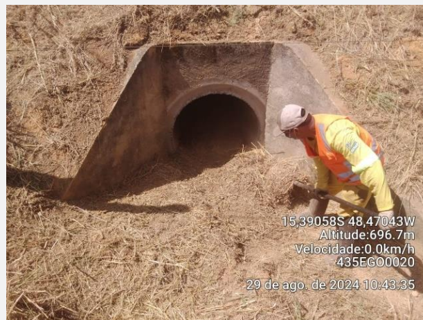
Imagem 24 – Desobstrução de Bueiro
